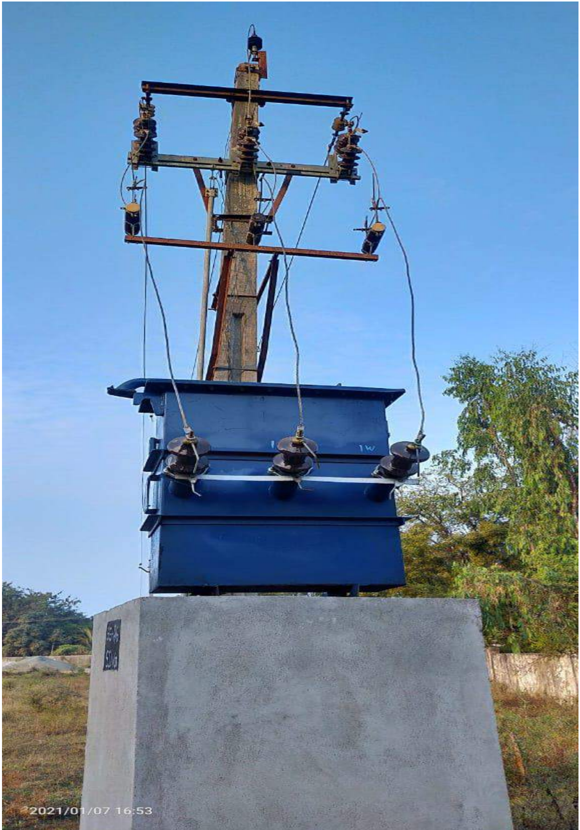
MINI TRANSFORMER (1x25 KVA) for 15 KW LOAD
