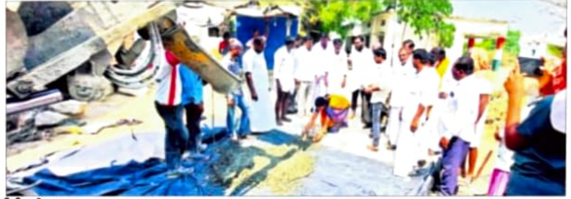
సీసీ రోడ్డు పనులను ప్రారంభిస్తున్న మంజుల
